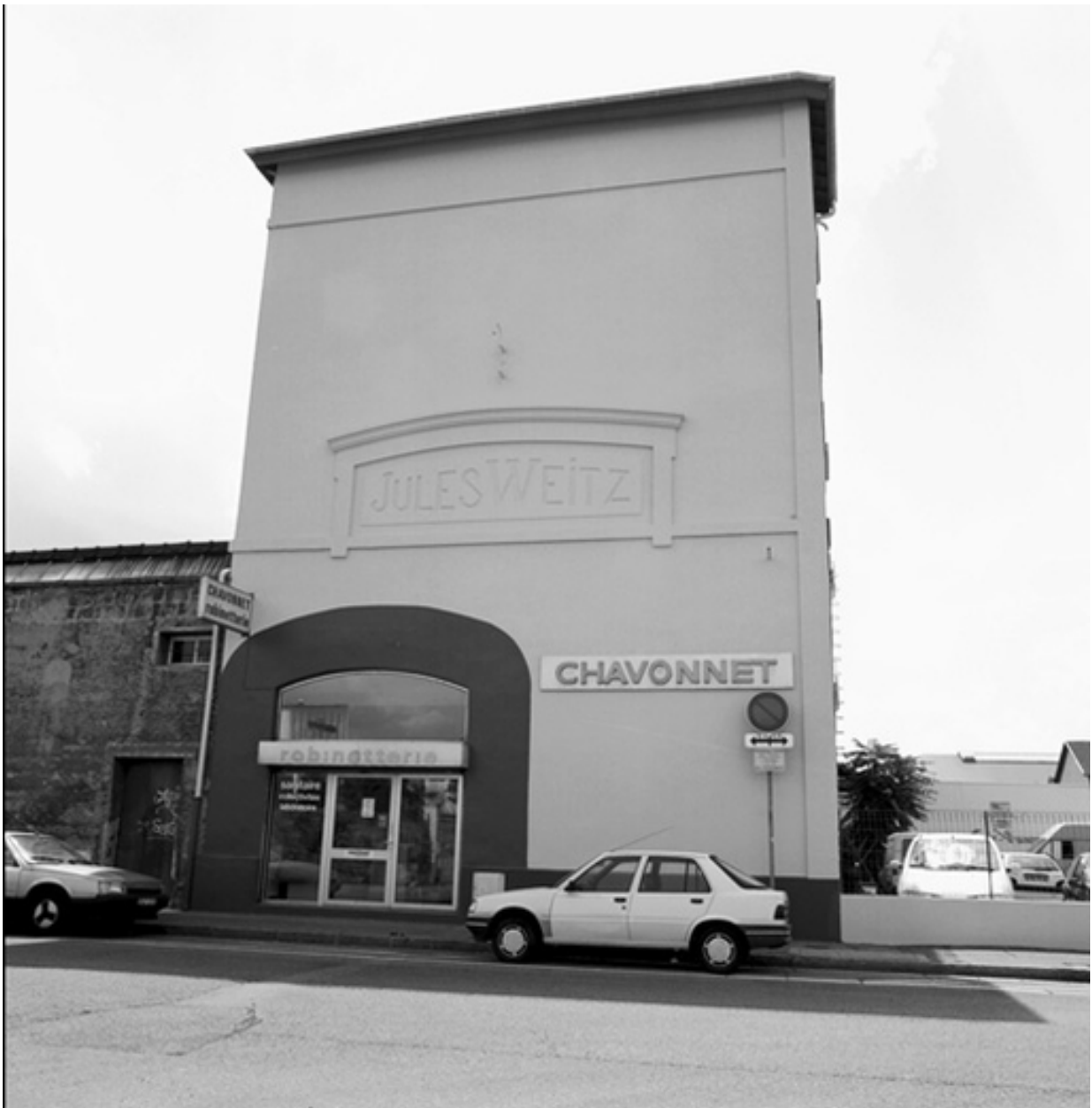
Vue générale façade nord
