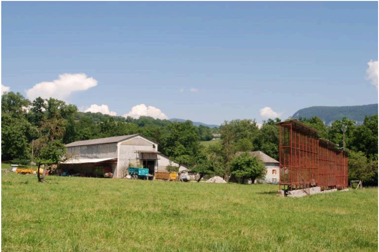
Vue générale depuis le sud-ouest.
