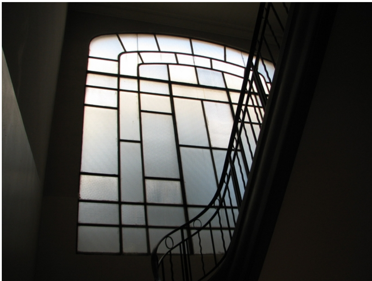
Détail baie de la montée d'escalier
