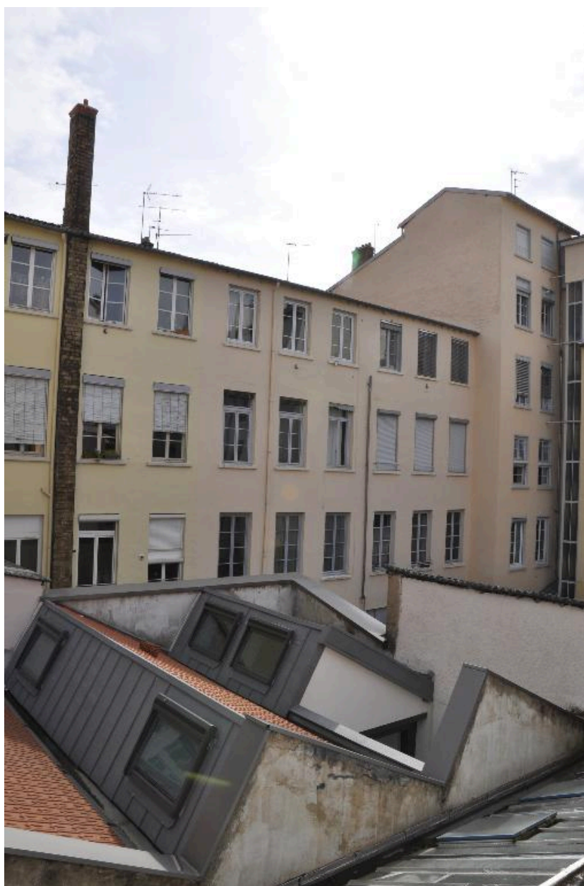
Vue arrière de l'immeuble
