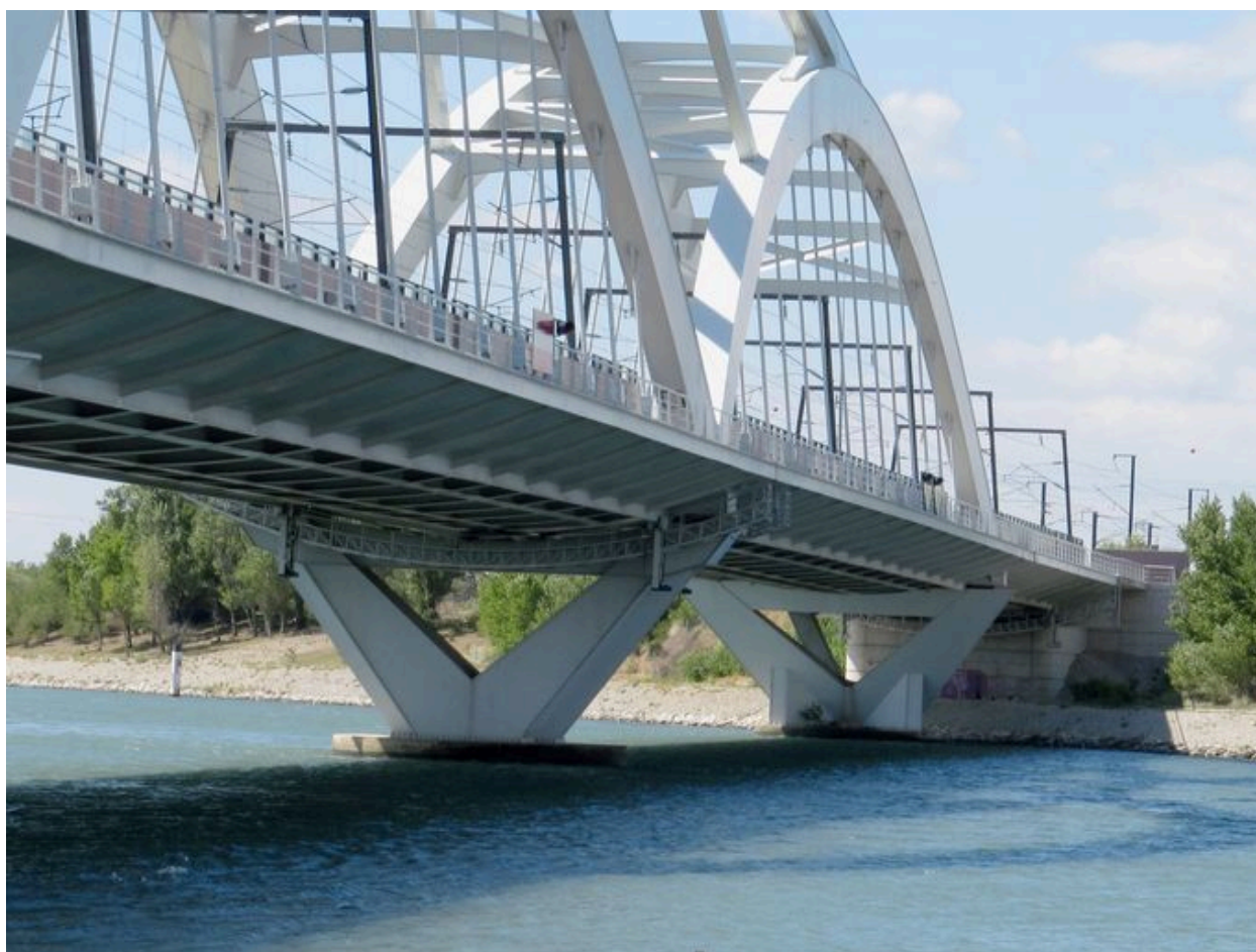
Vue partielle, de côté, face amont (depuis la rive gauche)
