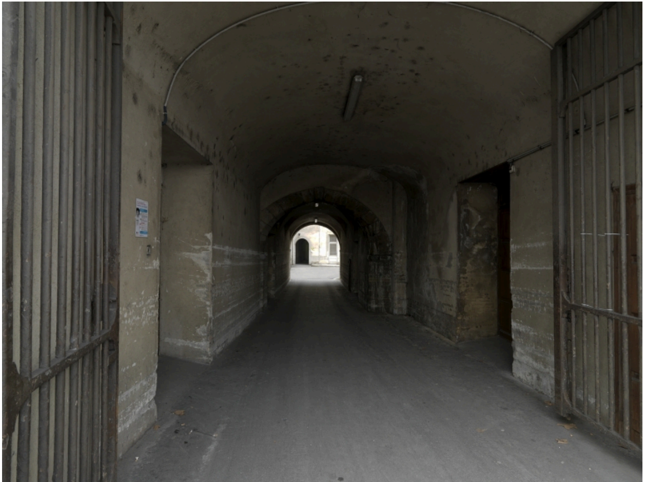
Bâtiment K. Le passage couvert depuis l'entrée
