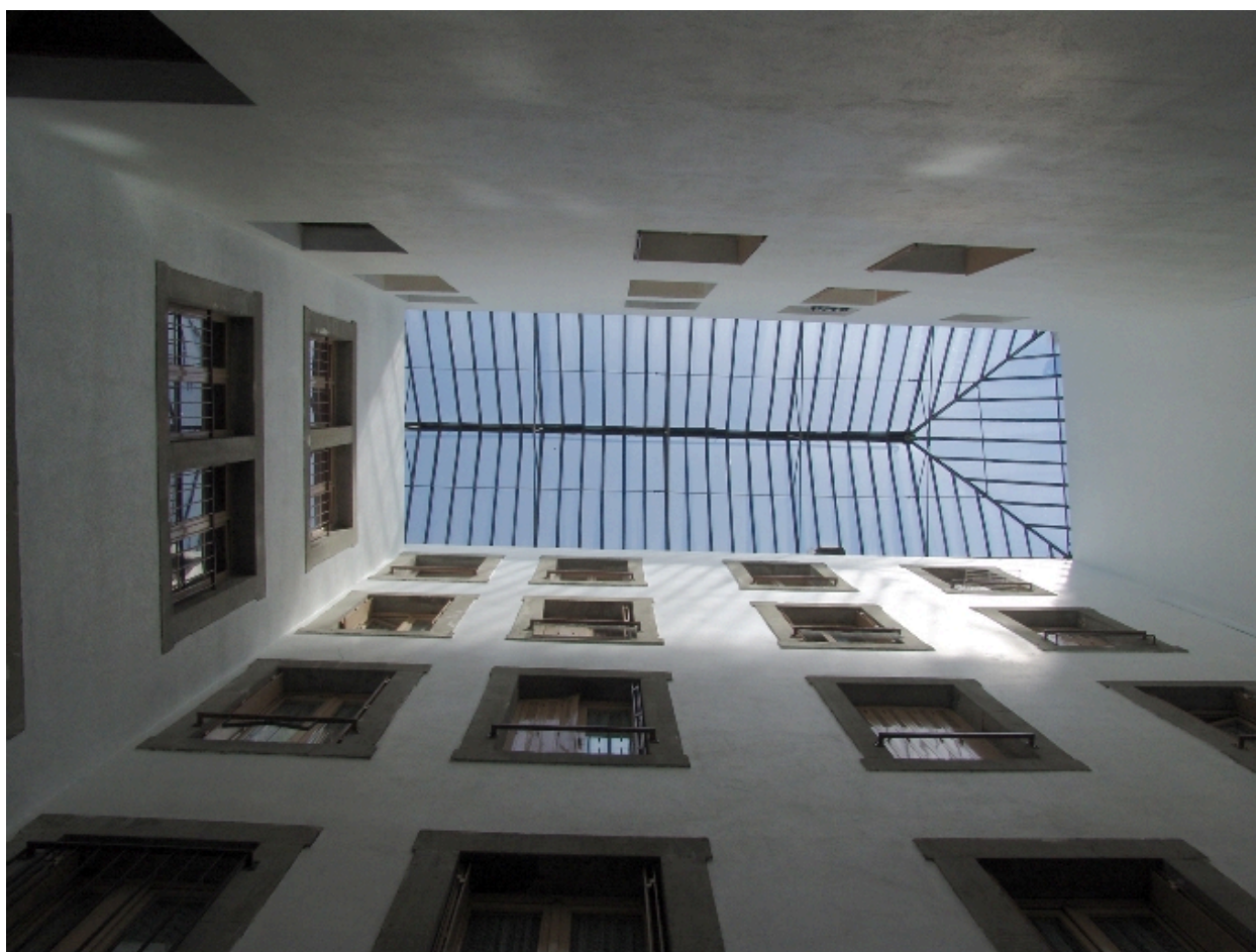
Verrière de la cour intérieure
