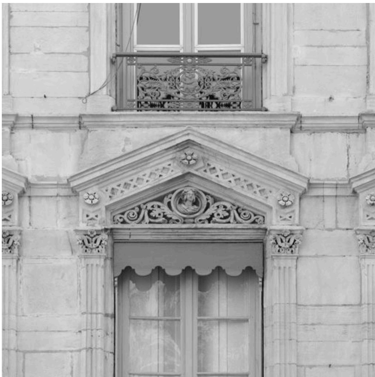
Elévation quai Saint-Antoine, troisième travée à partir de la gauche : fronton sculpté du premier étage carré et garde-corps du second
