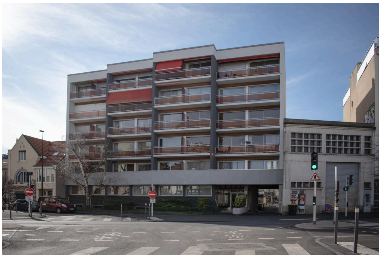
Façade sur le boulevard Aristide-Briand
