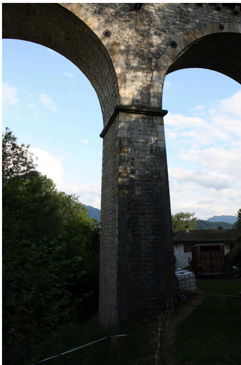
Viaduc du Gantet, détail pile
