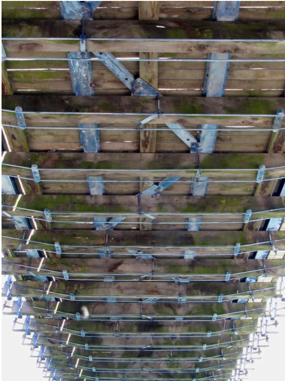
Vue partielle, de dessous, tablier (depuis la rive droite)
