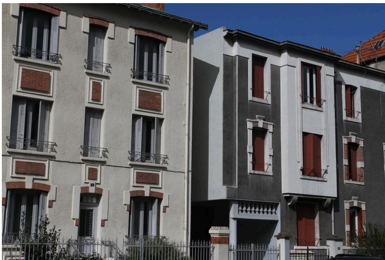
Détails des façades sur le boulevard
