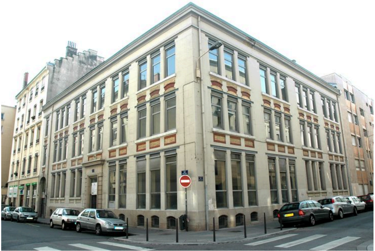
Vue générale de l'immeuble depuis le nord-ouest
