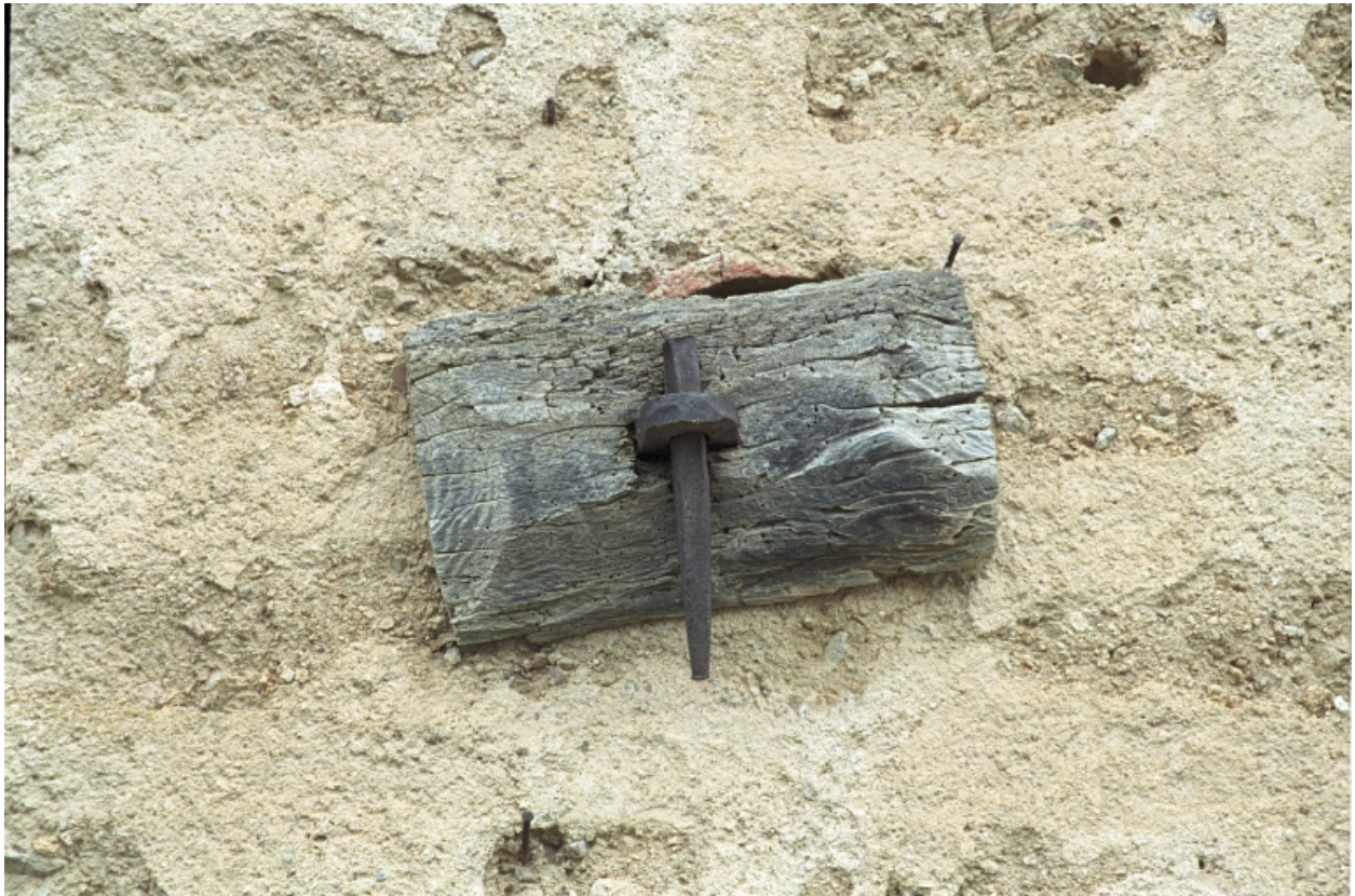
Saint-Laurent-Rochefort, Grossat, ferme (1987 B1 109). Tirant en métal.
