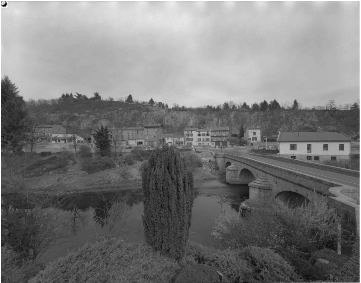
Vue du pont, de l'ouest.
