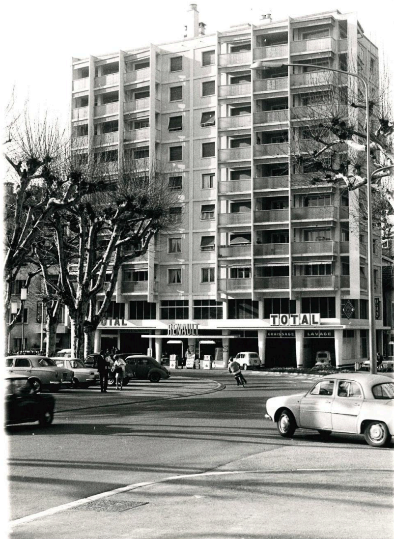
Immeuble Le Floride et Garage Perrel, vue d'ensemble prise depuis le nord-est, photographie vers 1965
