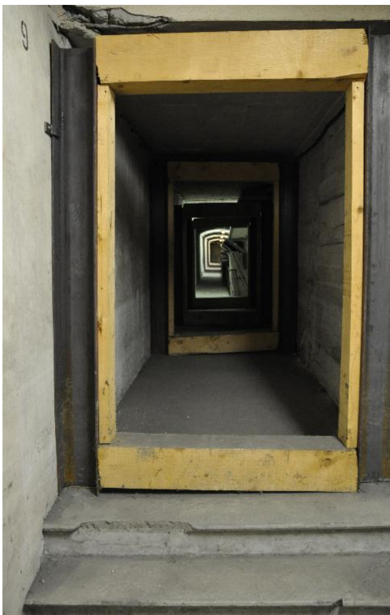
Vue des galeries étagées au sous-sol
