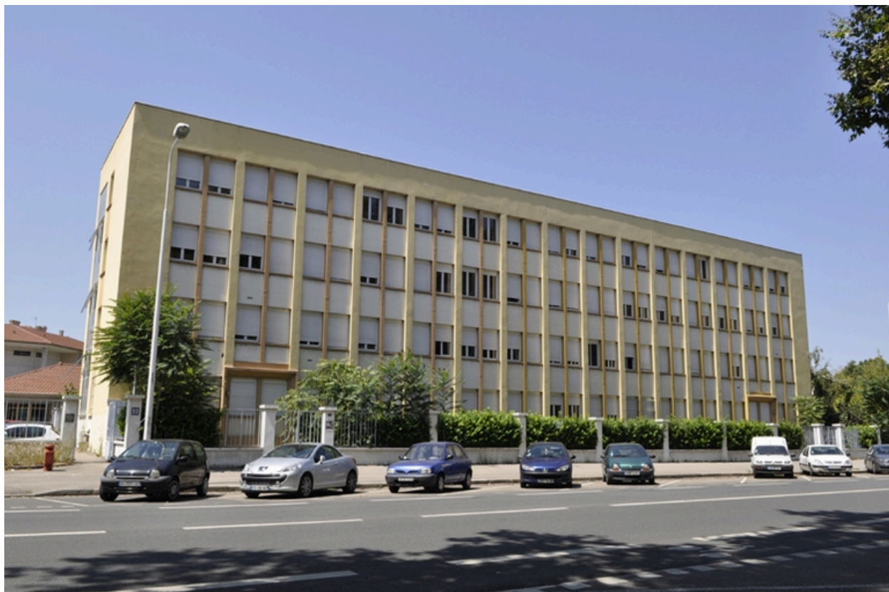
Bâtiment construit dans les années 70. Vue prise depuis le boulevard Yves Farges.
