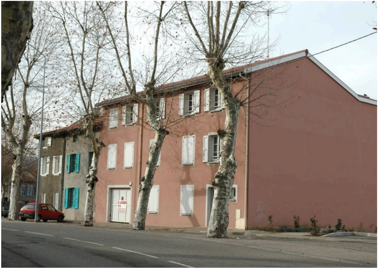
Vue générale depuis le boulevard Duguet.
