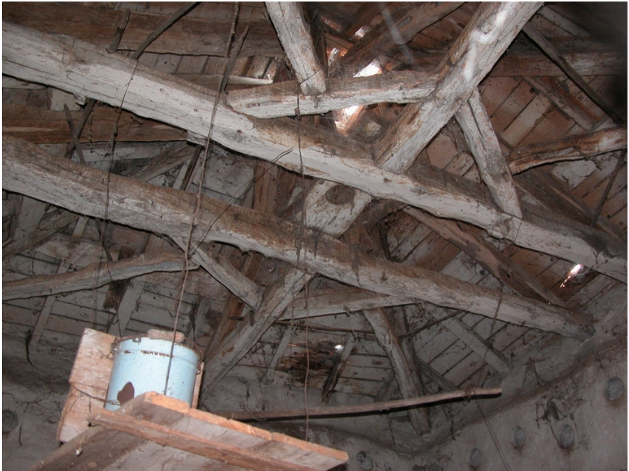
Vue intérieure : charpente.
