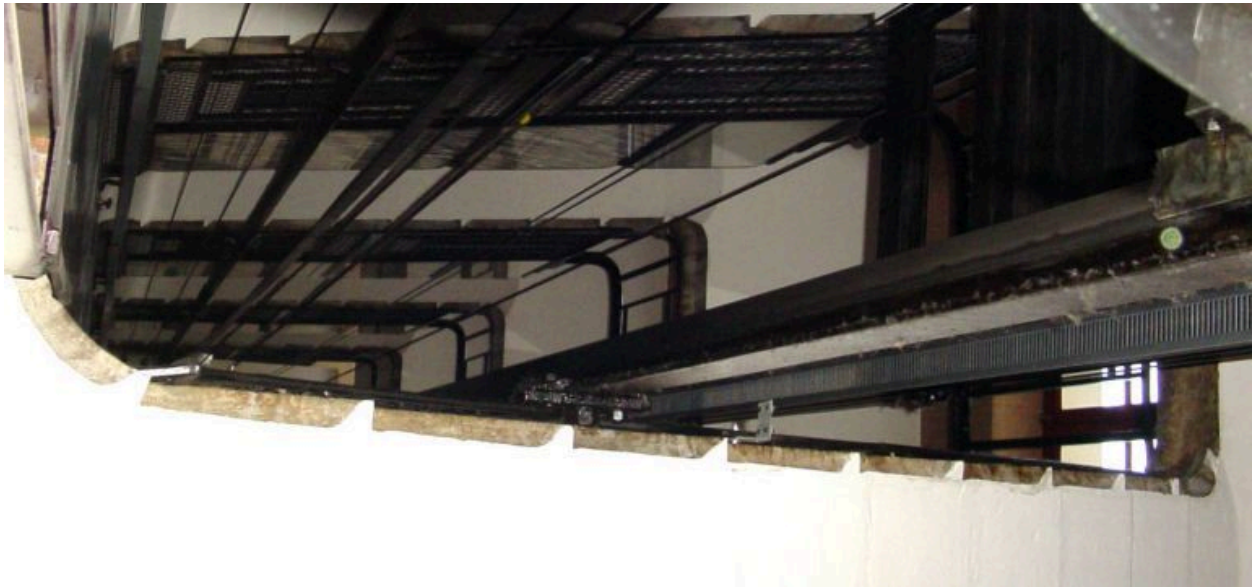
Cage d'escalier vu du dessous
