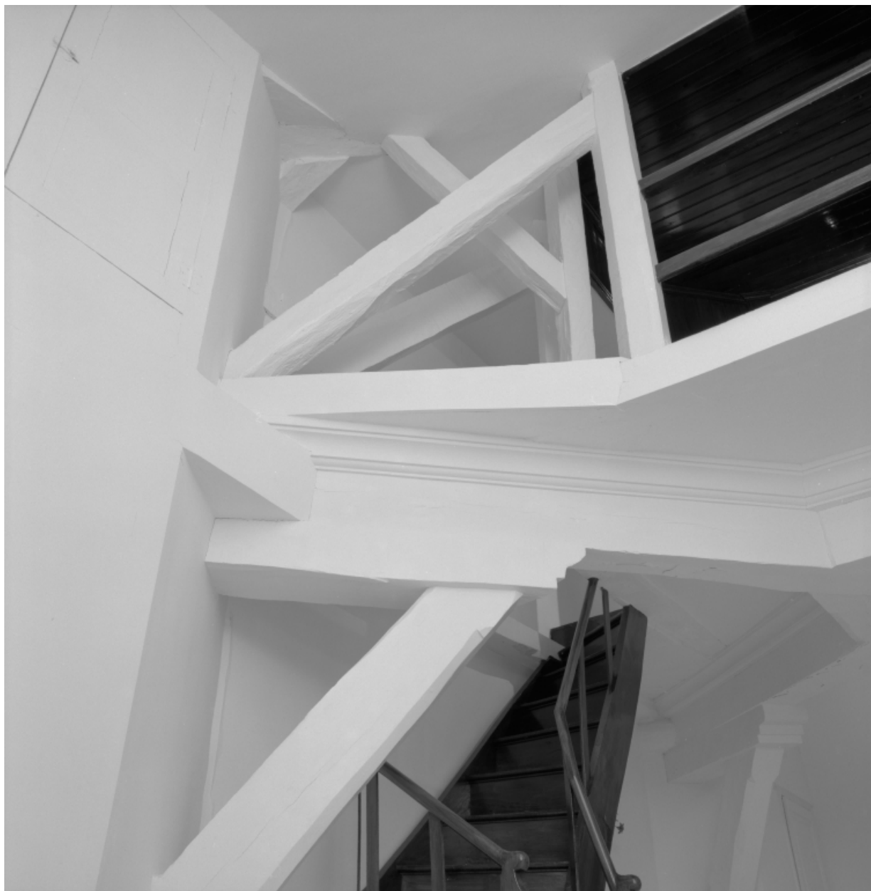
Etage de comble : détail de l'enrayure portant le belvédère.
