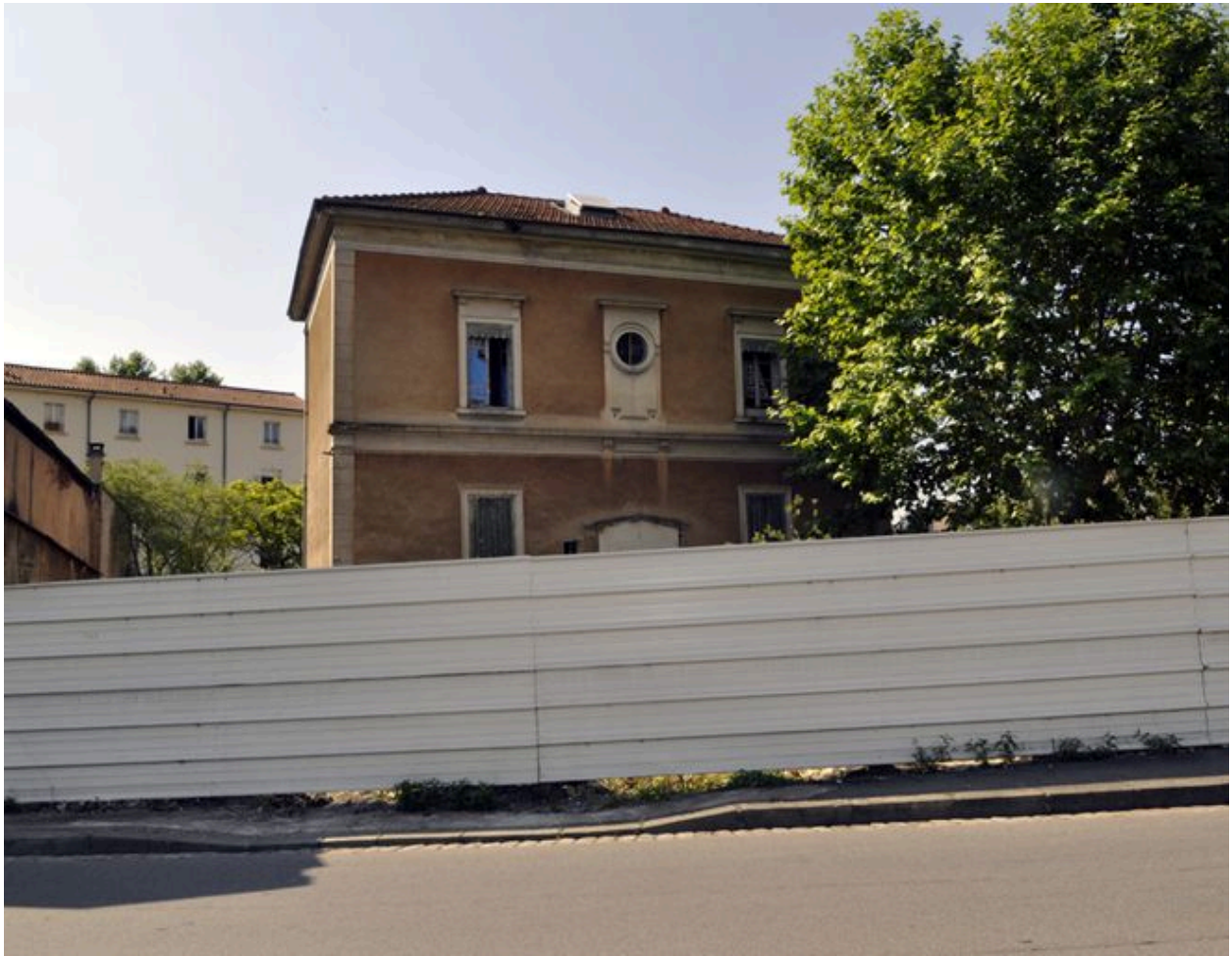
Élévation postérieure donnant sur la rue Joannès-Carret, état au 25 juin 2009
