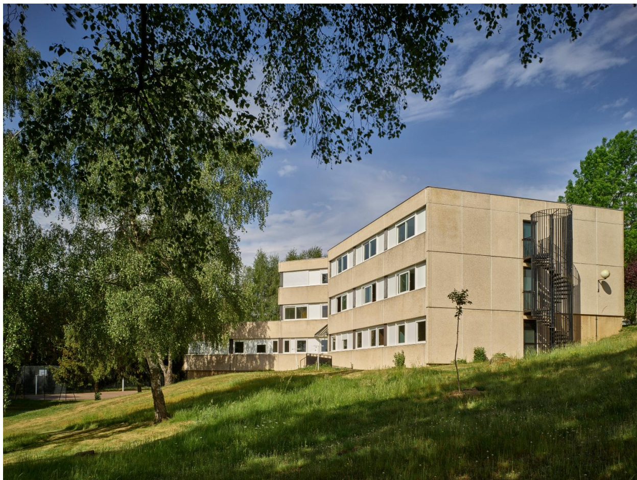
Bâtiment de l'internat vu depuis le sud-est.
