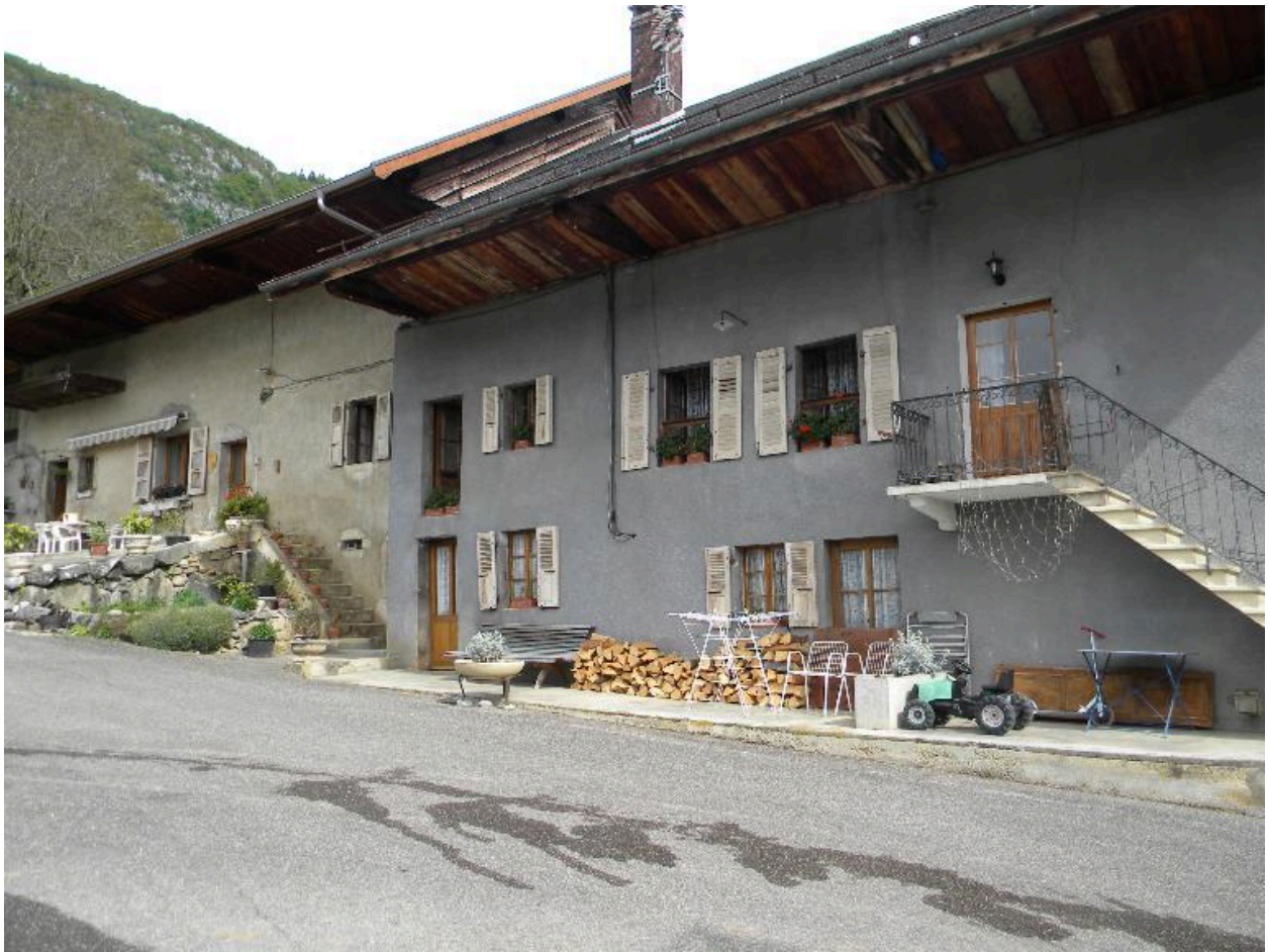
Vue de la façade de deux fermes mitoyennes (2008 842, 1167, 1759).
