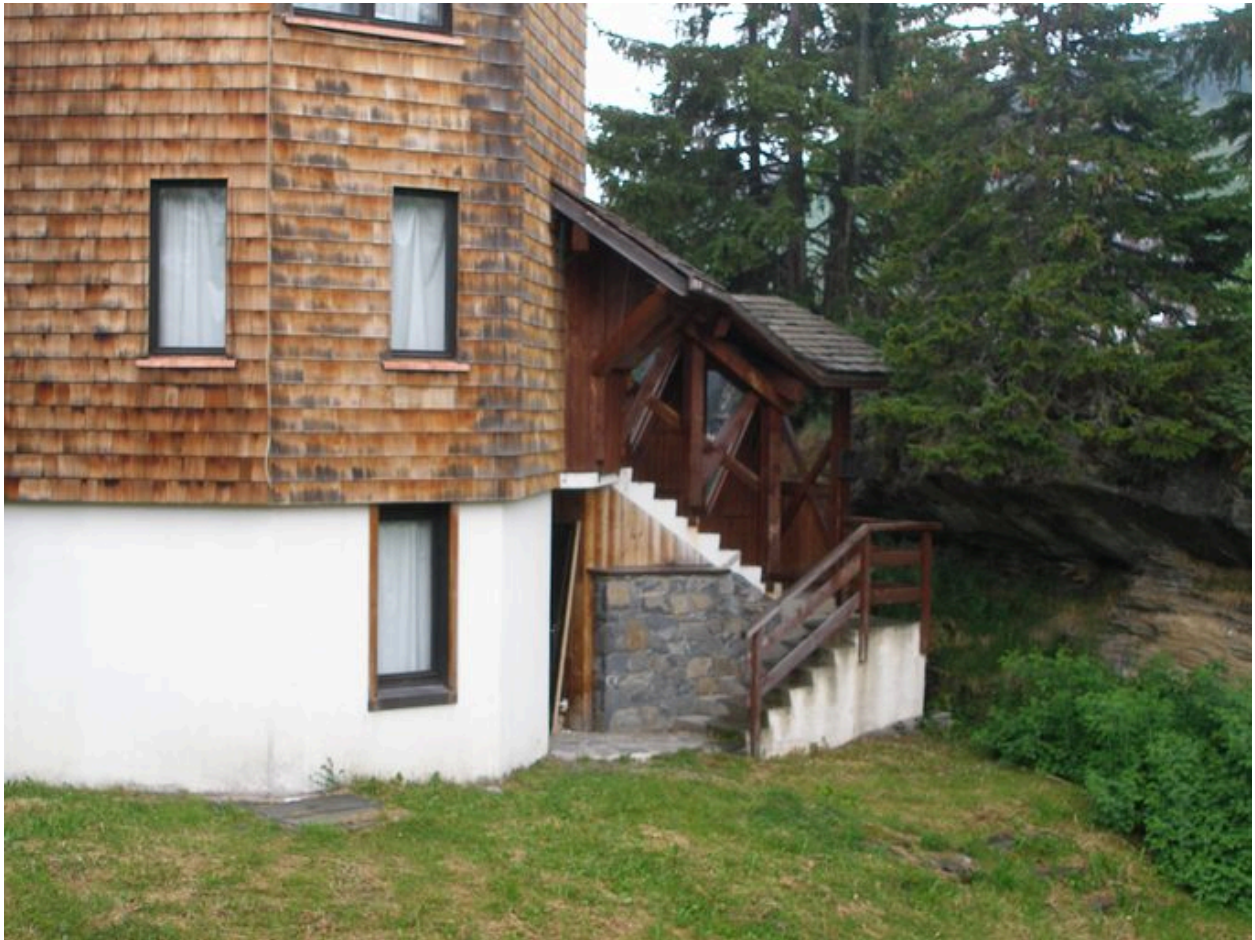
Elévation est. Détail de l'entrée
