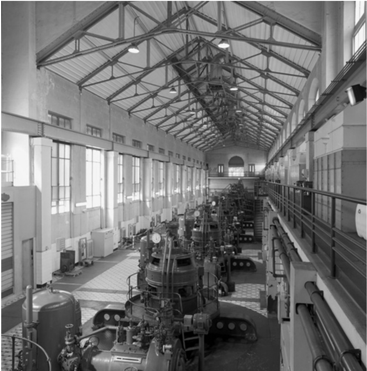
Vue d'ensemble nord
