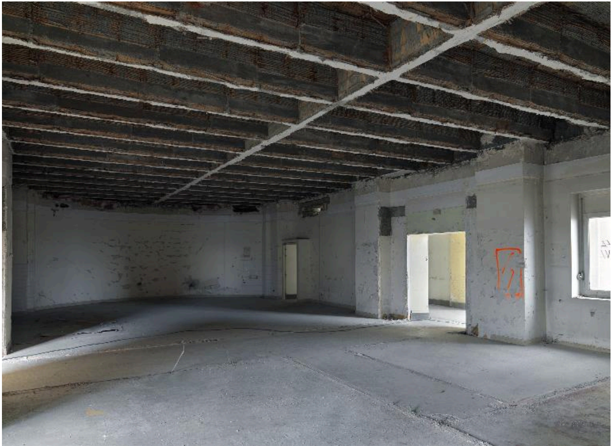
Etat en janvier 2015 : bâtiment B, partie centrale, dalle à coffrage perdu
