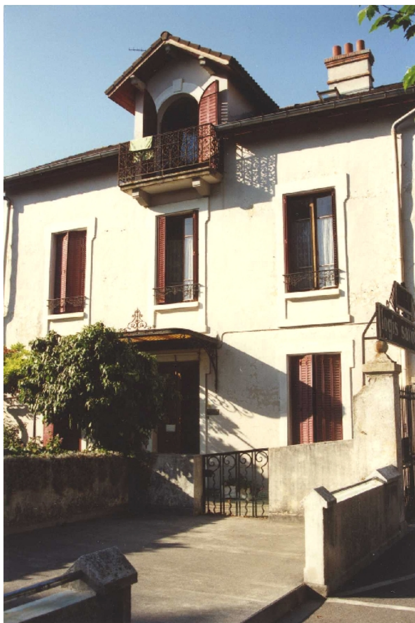
Façade sud, avant démolition
