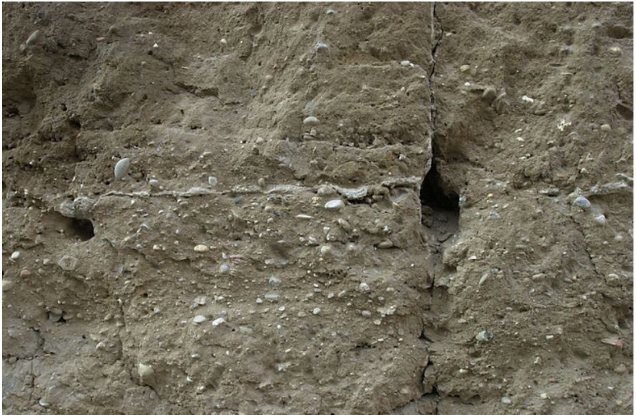
Détail du mur de clôture
