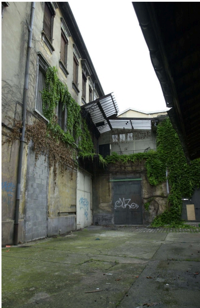
Vue de la cour du côté de l'entrée
