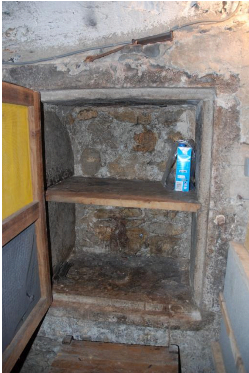
Sous-sol, petit placard mural situé à droite de la porte d'accès à la cave voûtée.
