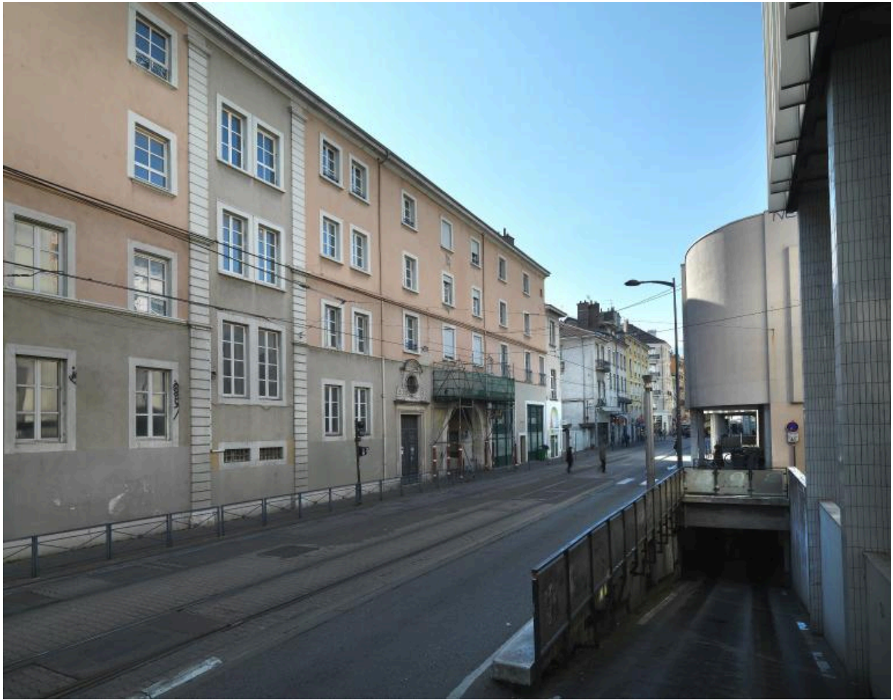
Elévation principale, vue partielle depuis l'est
