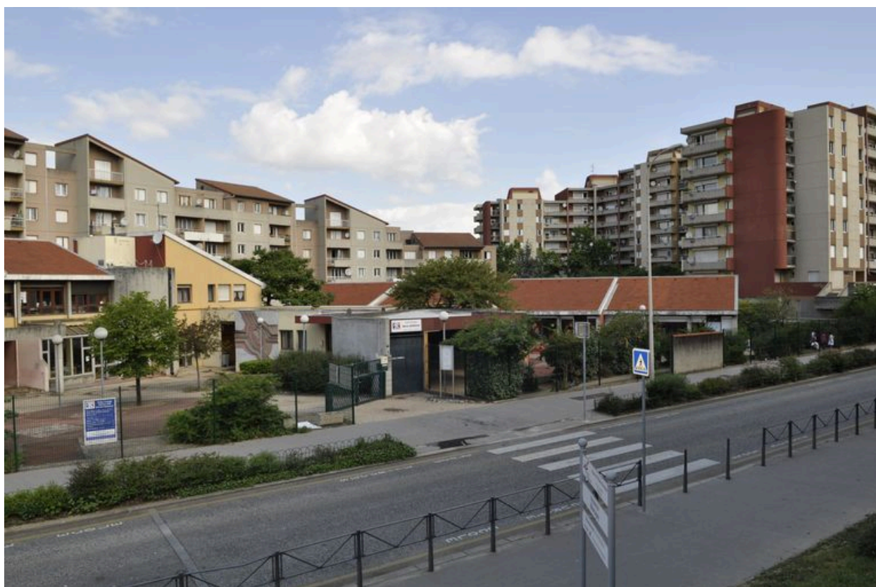
Vue de la partie nord du groupe scolaire : l'école primaire.
