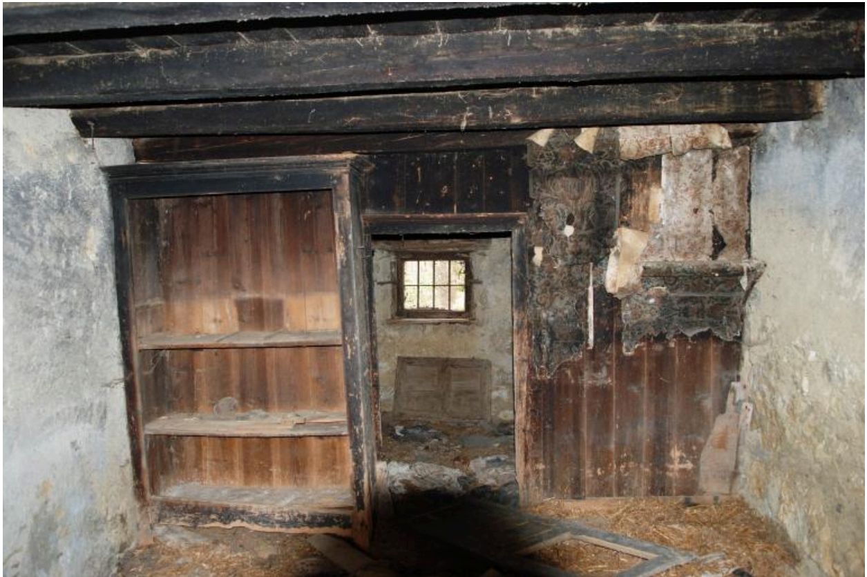
Vue d'ensemble intérieure de la cloison séparant la chambre de l'espace de rangement.
