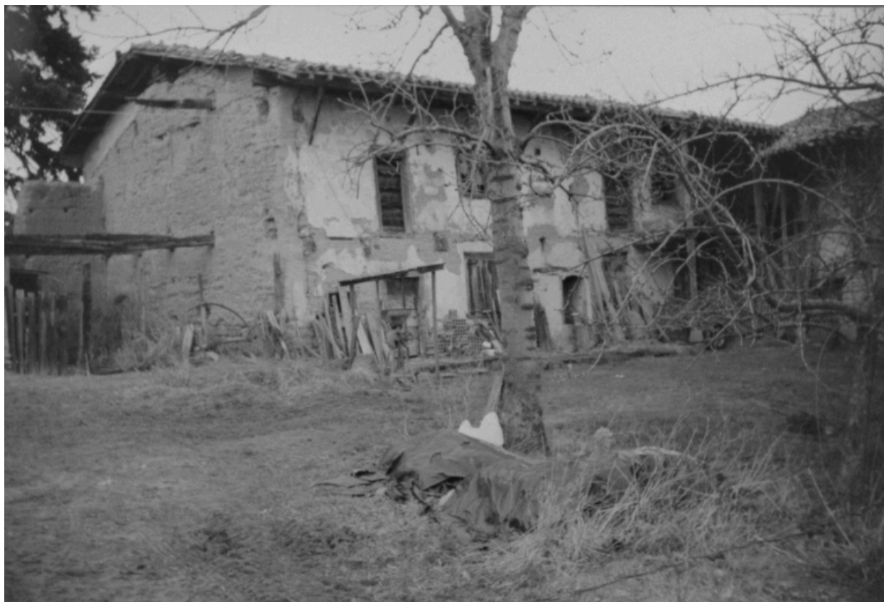
Saint-Sixte, la Treille (1987 A1 48), type C1. Vue d'ensemble avant restauration.
