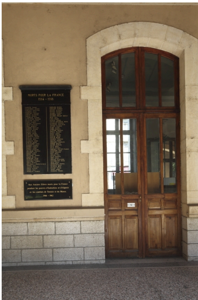
Cour H. Entrée de la loge d'accueil.
