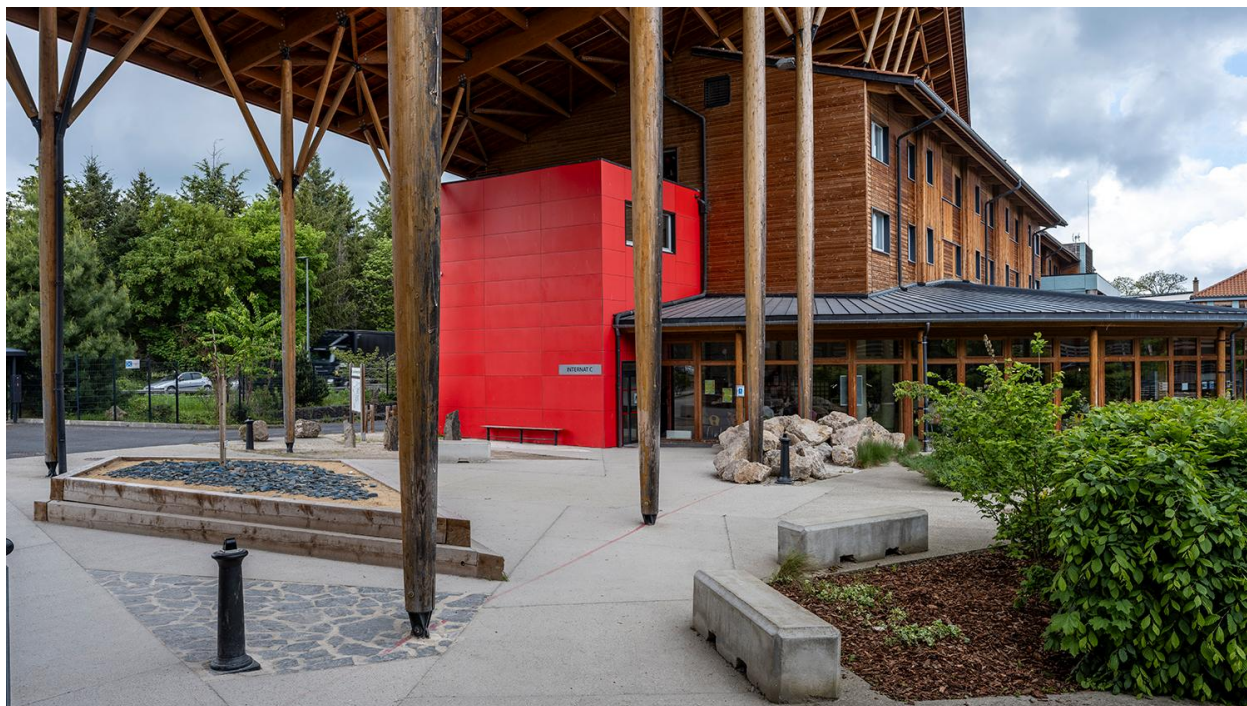
Vue d'ensemble de l'aménagement au niveau de l'entrée du lycée, depuis le sud-est
