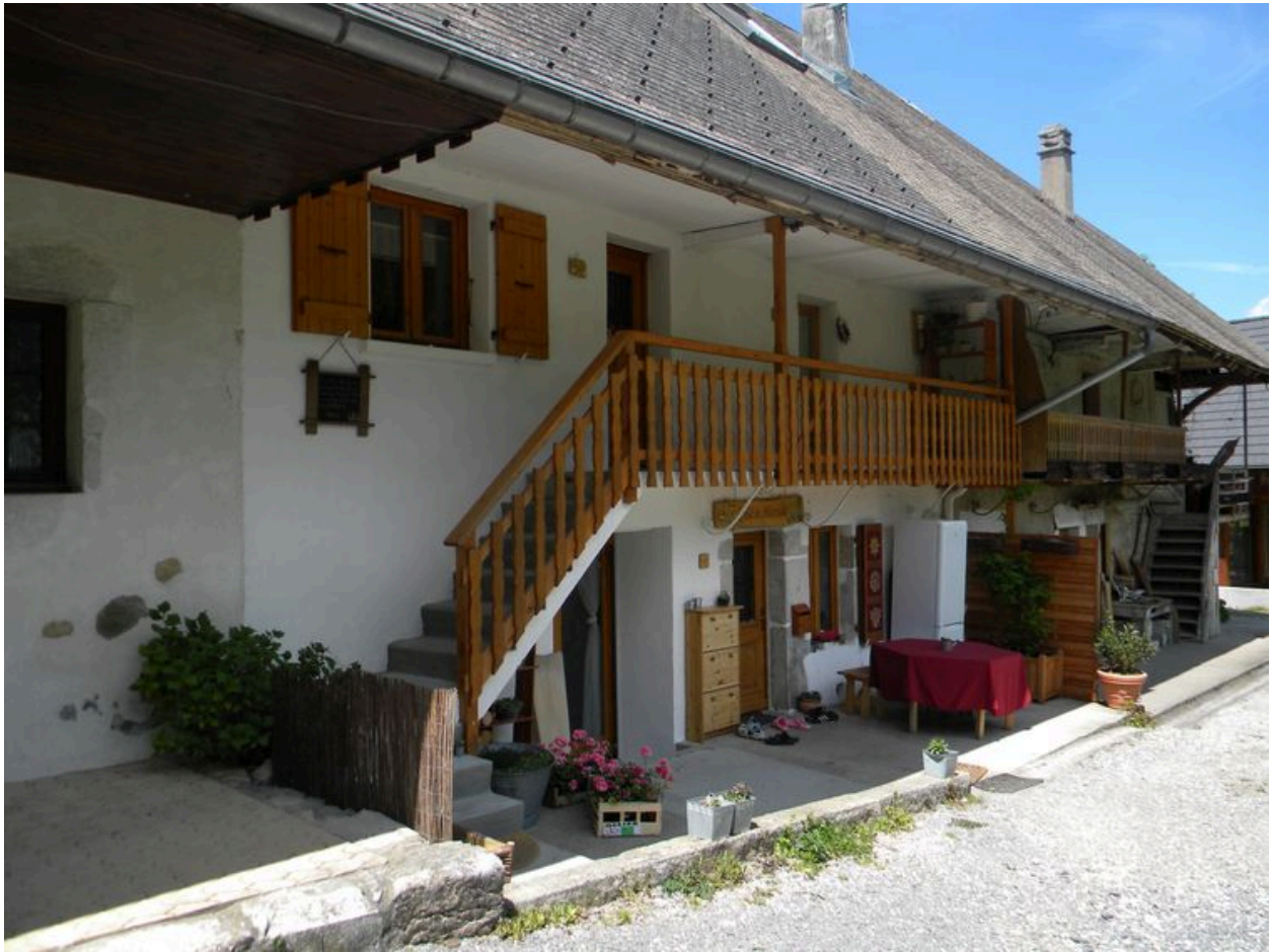
Vue de la façade principale de l'ancien commerce.
