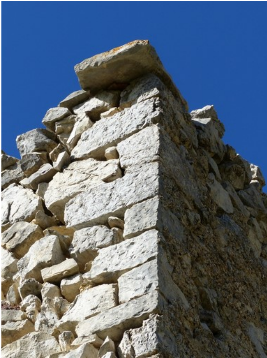
Chaîne d'angle en pierre de taille. Entrepôt agricole au village.
