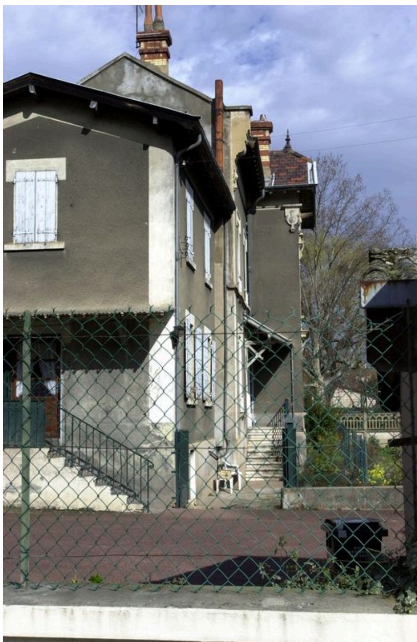
Vue de l'élévation sur jardin
