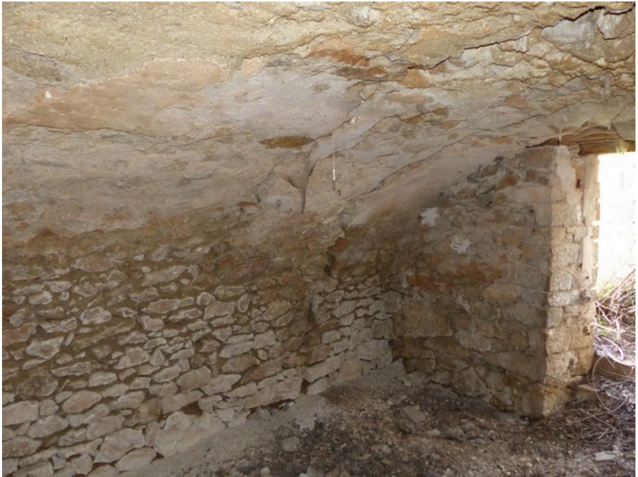
Etage de soubassement, étable. Vue de volume prise du nord-ouest.
