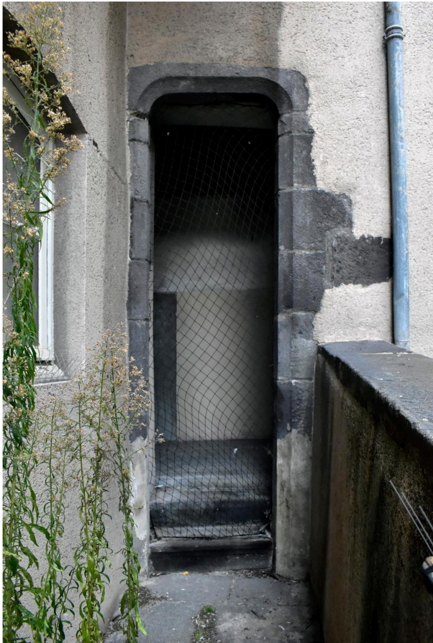
Corps de bâtiment en fond de cour, 1er étage : baie agrandie au niveau de la coursière (ouvrant sur les anciennes latrines)
