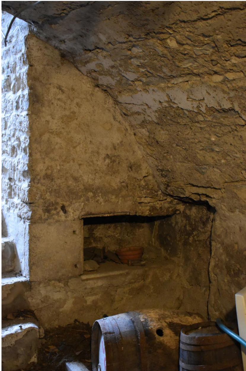
Détail d'une niche dans la cave.
