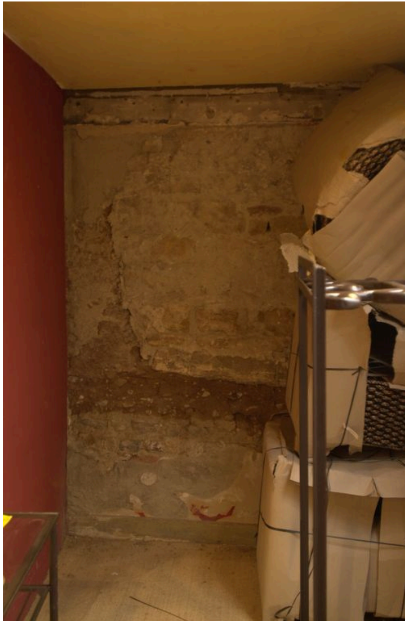
Détail d'un mur en pisé
