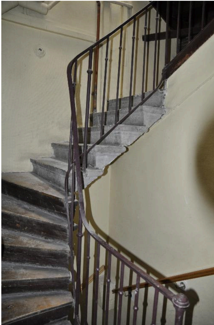
Vue de la deuxième volée de l'escalier
