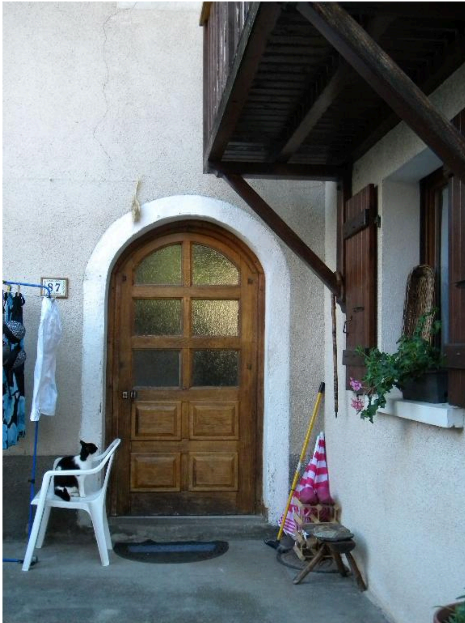
Vue d'une porte en plein cintre servant autrefois de passage.
