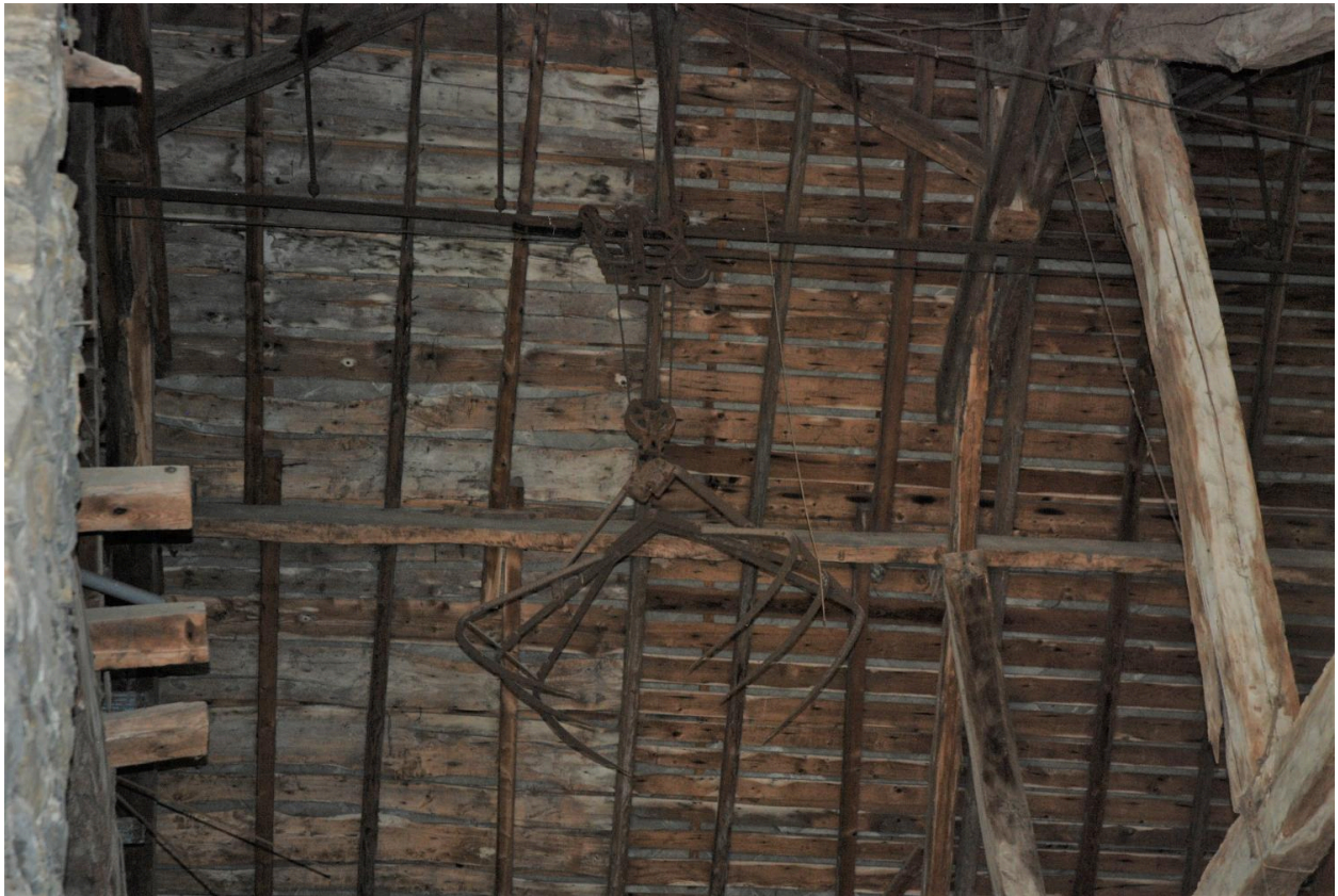
Partie nord. Grange-étable (2018 E1 525, rue Jacques Marret). Détail de la griffe monte-foin.
