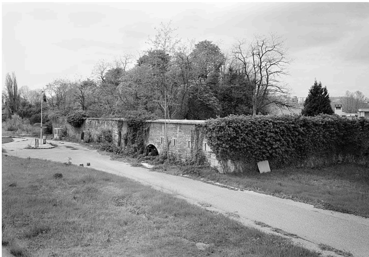
Face droite du bastion 1
