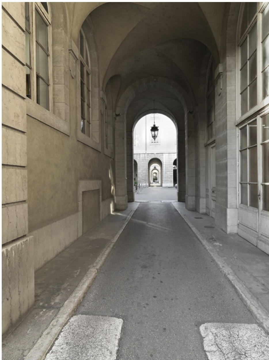
L'enfilade des passages couverts reliant les cours depuis le sud
